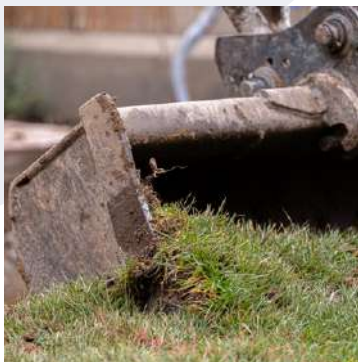
01. Excavation de la surface de la terre
