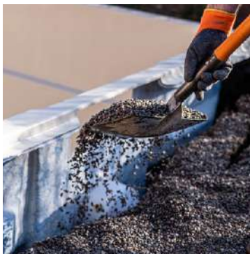
05. Remplissage des côtés de gravier
