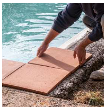
08. Pose de l'arrêt périmétrique
