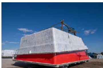
07. Démoulage de la piscine
