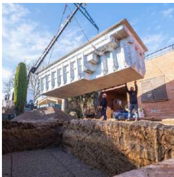
03. Pose de la piscine dans le trou
