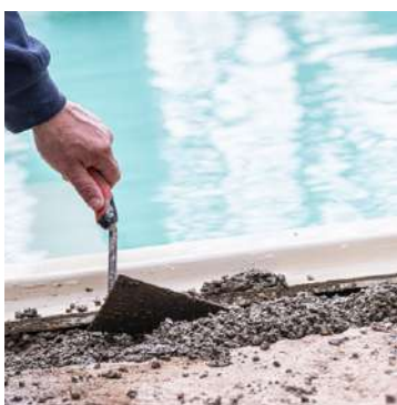
07. Remplissage du revêtement avec du ciment pour la pose des parois
