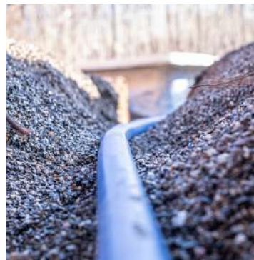
06. Installation des tuyaux
