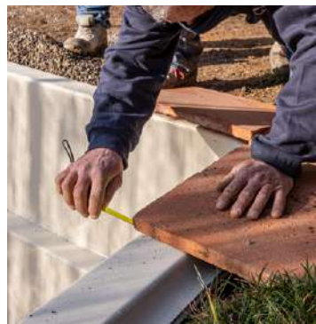
04. Mise à niveau de la piscine
