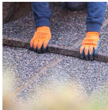
02. Préparation de la base avec un revêtement de gravier
